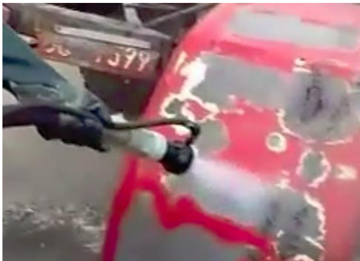
Adaptador úmido em jateamento pressurizado.
