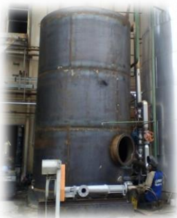
Exemplo de superfícies de aço com carepa de laminação no Grau A
