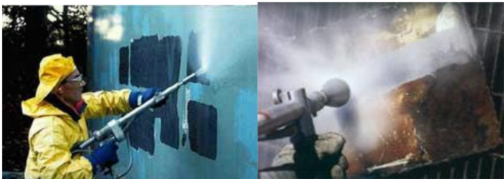
Operação de Hidrojateamento (Zirtec)
